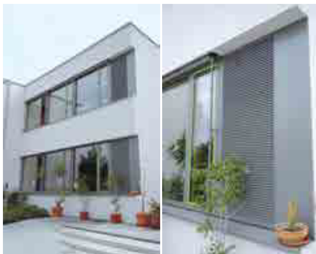
■ Nachrüstungen rechts neben den Fenstern von außen.
