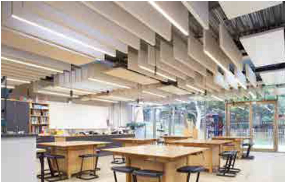
■ Staub kann sich entzünden. Deswegen sind in Werkräumen Leuchten angebracht, die gegen Entzündung und Entflammung geschützt sind. (Foto: licht.de/Ridi)
